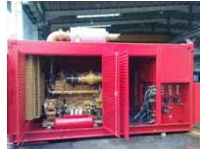
Пожарный водяной насос
